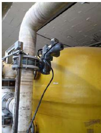
Électrovannes des filtres à sable de la Station de Jungholtz (3 motoréducteurs renouvelés sur 2021).
