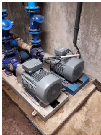
Deux pompes de lavage des filtres à sable de la Station de Jungholtz (un moteur a été remplacé pour une des deux pompes ; quant à l'autre pompe, la partie volute a été remplacée).
