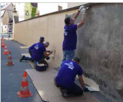
Mur du presbytère
