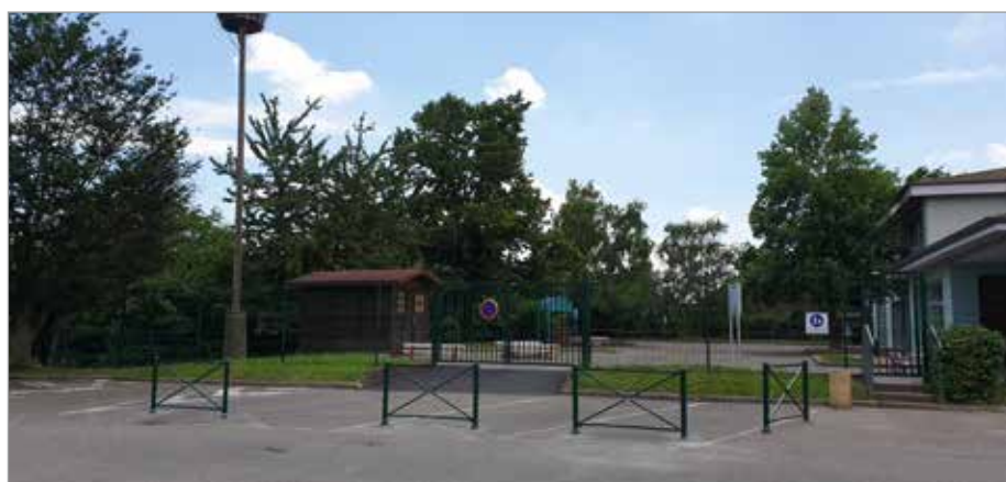
A l'école Belle Vue, le nouvel accès rénové de la cour a été entrepris
