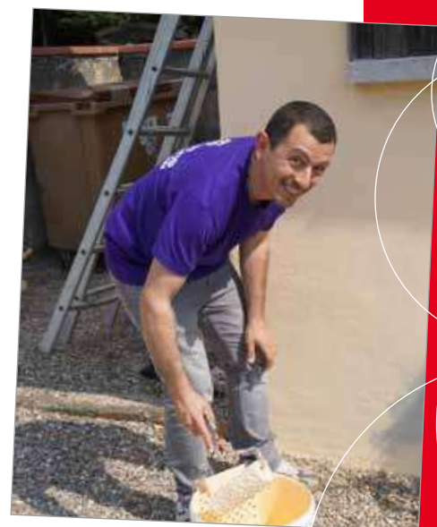
M. le Maire, Marcello Rotolo. Réfection du mur du cimetière
