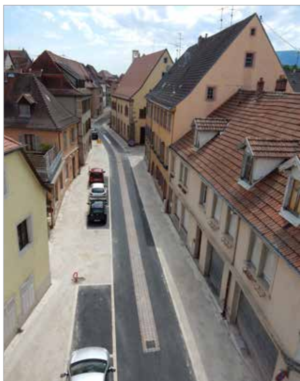
Rue Jean Jaurès terminée
