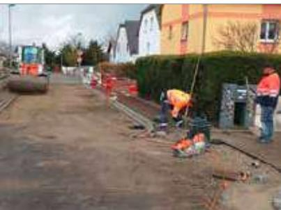
Après la pose de la bande de roulement en partie haute de la rue avant l'hiver, un fil d'eau en pavés granite permettant de canaliser les eaux pluviales, complété d'un trottoir pour sécuriser les piétons, ont achevé
