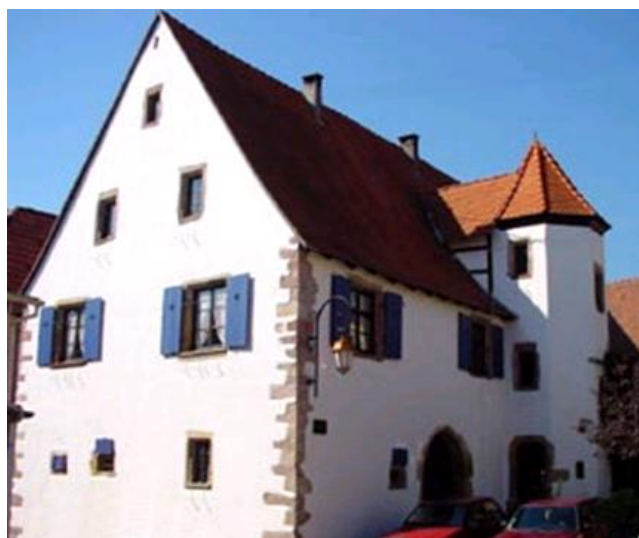
Une maison typique de Soultz, dans la rue des Charrons
