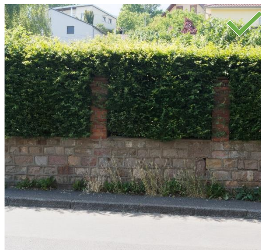
Mur-bahut en pierre doublé d'une haie végétale
