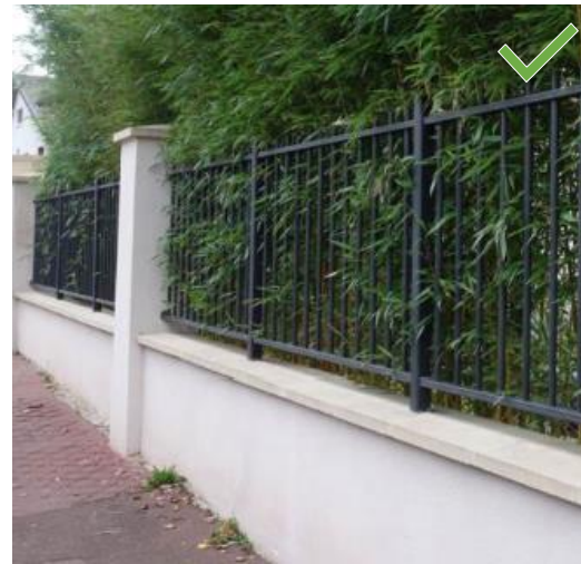
Dispositif de claire-voie non opaque avec un barreaudage en ferronnerie de conception simple et doublé d'une haie vive végétale
