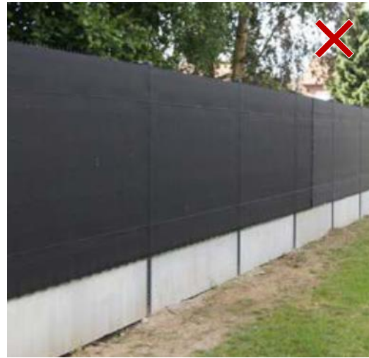
Brise-vue en toile ou bâche = dispositif opaque
