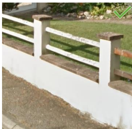
Mur-bahut surmonté de lisses (dispositif non opaque)
