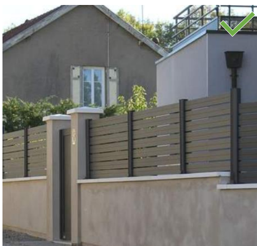
Mur-bahut surmonté d'un dispositif de type claire-voie / Couleurs en harmonie avec l'environnement
