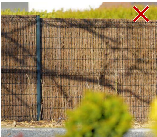
Occultation d'un grillage rigide réalisé avec des brandes de bruyère = dispositif opaque
